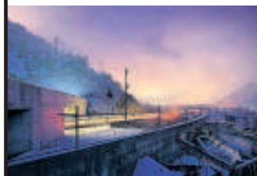
Der Lötschbergbasistunnel ist bereits heute gut ausgelastet. Bild: Keystone
